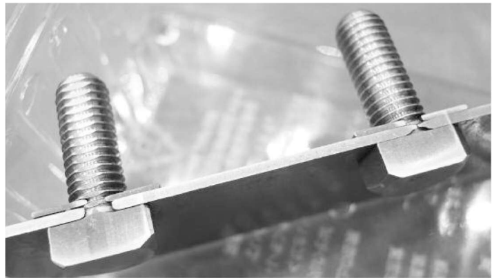
カットモデル※左側がヨッシャー締結前の状態で片側の左半分がねじ山を乗り越えていないので隙間がある、右側がヨッシャー締結後の状態
